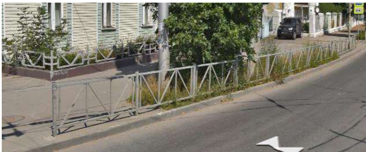
Рисунок 23. Ограждение на ул. Чкалова, четная
