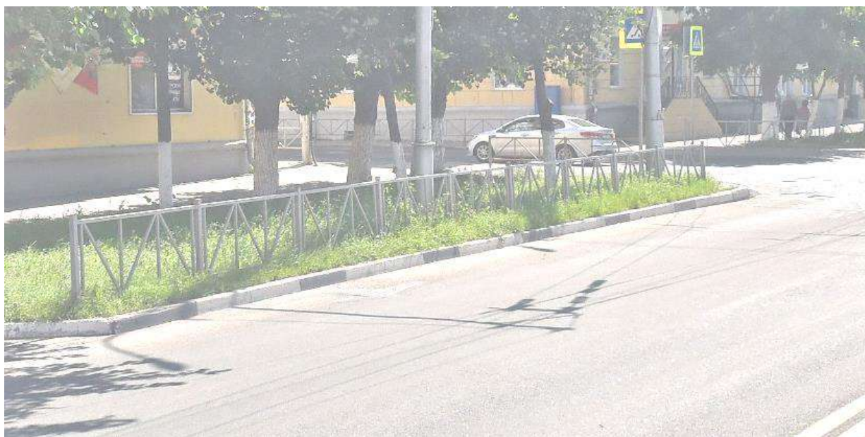
Рисунок 35. Ограждение ул. Циолковского, на пересечении улицы Новая Дислокация знаков дорожного движения в г. Рязань
